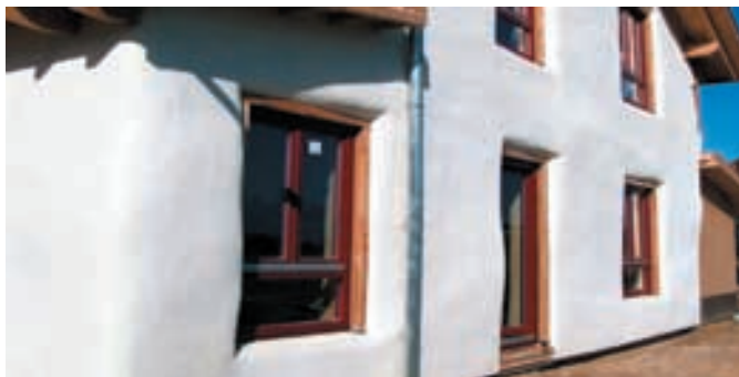
Diese Fotos zeigen Musterhäuser in verschiedenen Stadien während des Rohbaus
