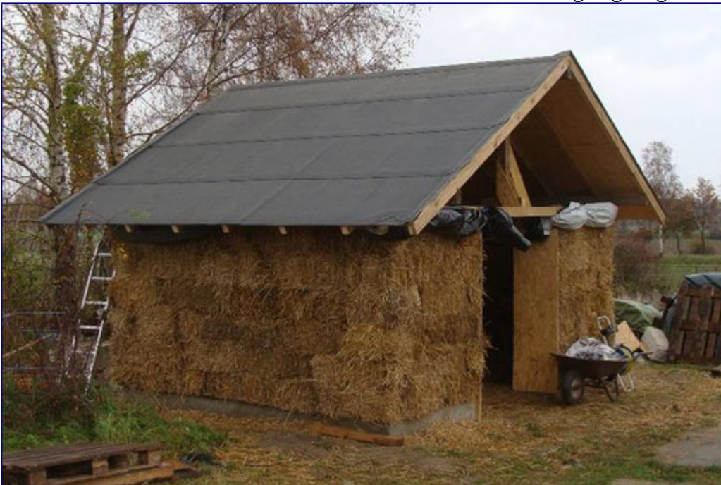
Strohballenhaus: Das lasttragende Strohballenhaus steht im Rohbau und wird im laufenden Jahr vollendet.
