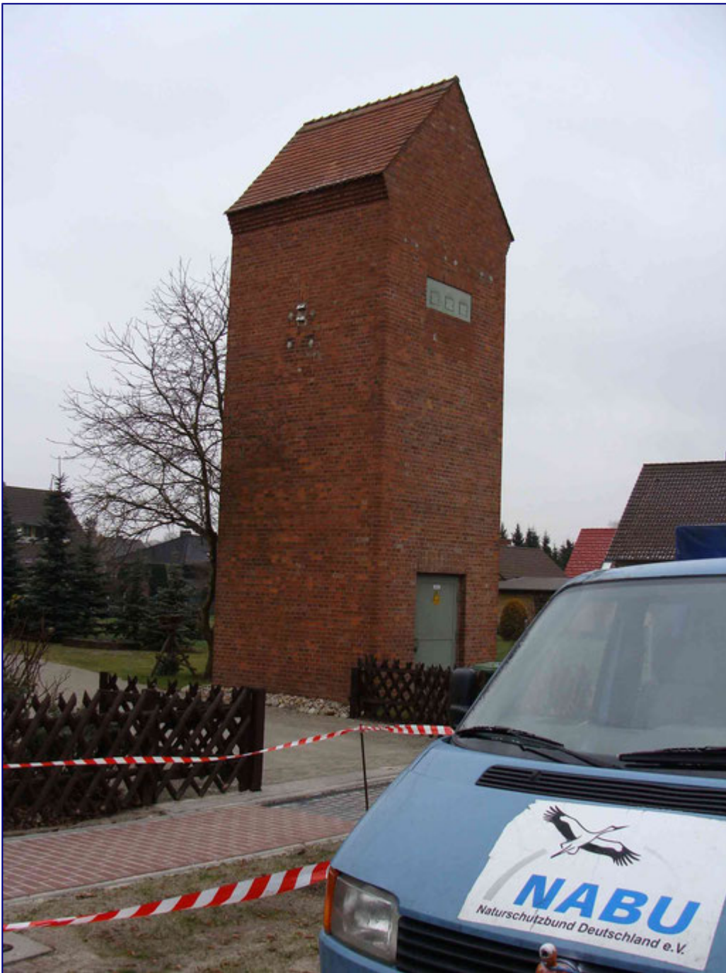
Umspannturm in Wagenhoff, bald mit Storchennest?
